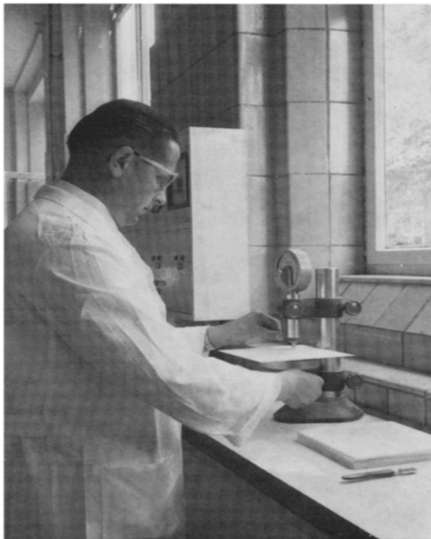
Fig. 4 Schichtdickenprüfung der DC-Fertigplatten (Fotografie E. Merck AG, Darmstadt).
